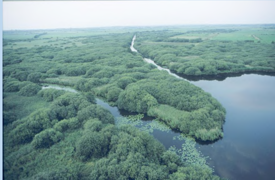
Polder zur Hochwasserentlastung der Treene
