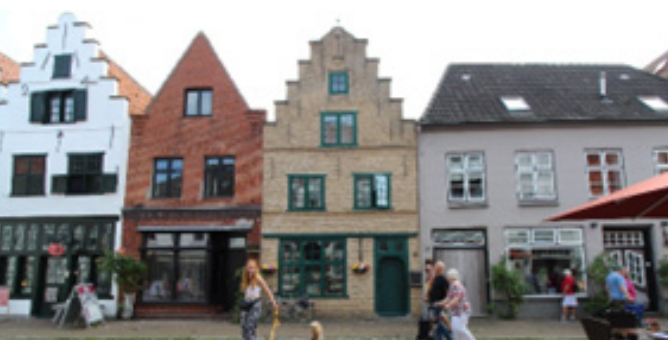
Abbildung 18: auch in der Prinzenstraße finden sich einige Gebäude aus der Gründungsphase
