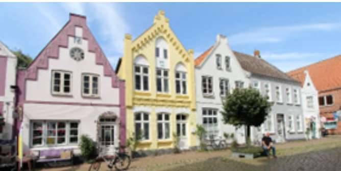
Abbildung 19: Gebäude aus der Wiederaufbauphase in der Prinzenstraße
