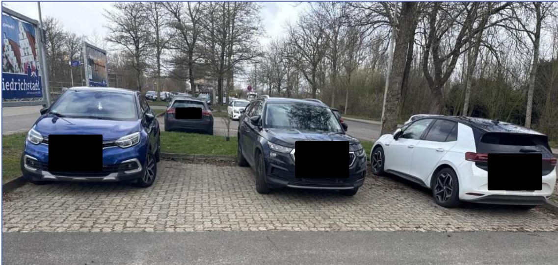
Abbildung 5.5: Ungenutzte Parkkapazitäten durch schlecht sichtbare Markierungen
